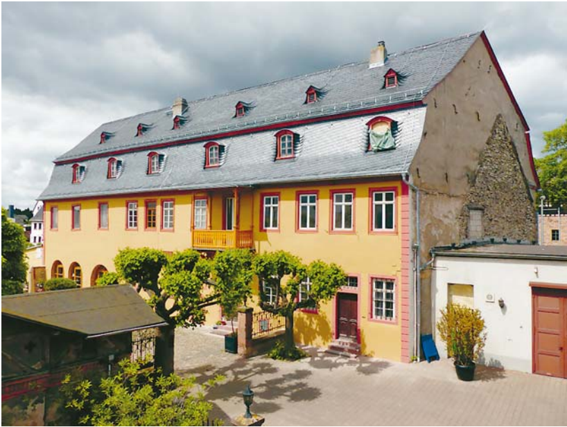
Abb. 7. Das Brentano-Haus nach der Außensanierung (Foto: privat).
